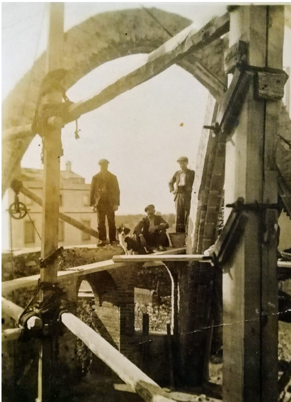
Imatge d'obra. Autor desconegut. Al voltant de 1921 Bastides de fusta, tres operaris i un gos a gran alçada.
